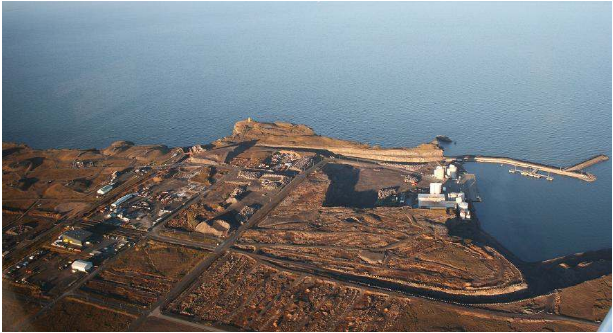
Mynd 2.1 Helguvíkurhöfn, Stakksbraut 9 og hluti iðnaðarsvæðis
